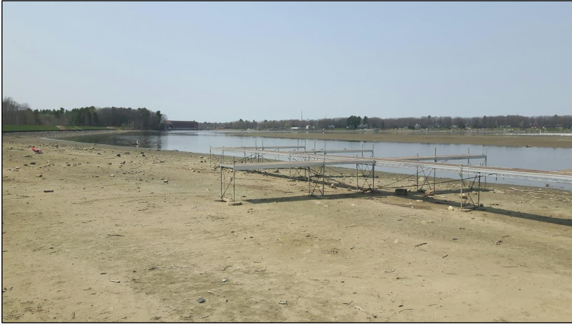
Photo 1. Réservoir du barrage de la Chute-Hemmings le 12 mai 2016. Cela correspond au niveau d'eau après l'abaissement du bassin pour la pose annuelle des haussoirs; juste avant le moment où la centrale limite l'écoulement pour remonter le niveau à la normale estivale.
