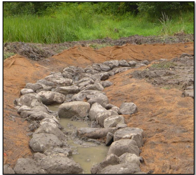
Photo 16. Mise en place de tapis anti-érosion (noix de coco)
