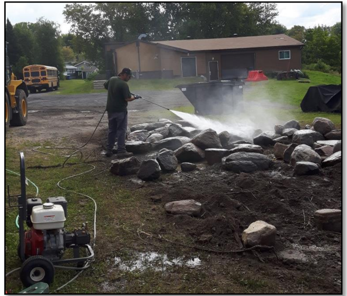
Photo 2. Nettoyage des roches avec machine à pression
