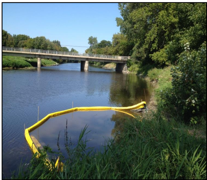
Photo 5. Rideau de turbidité installé dans le chenal Tardif
