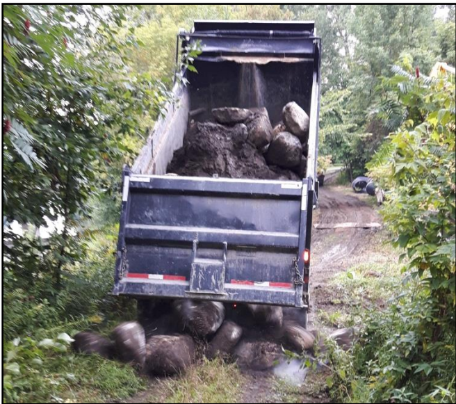
Photo 3. Transport des roches sur le site des travaux
