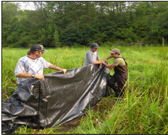
Photo 8. Mise en place du batardeau
