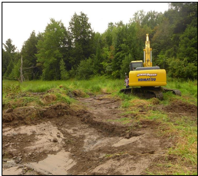
Photo 9. Excavation du cours d'eau – retrait de la couche organique
