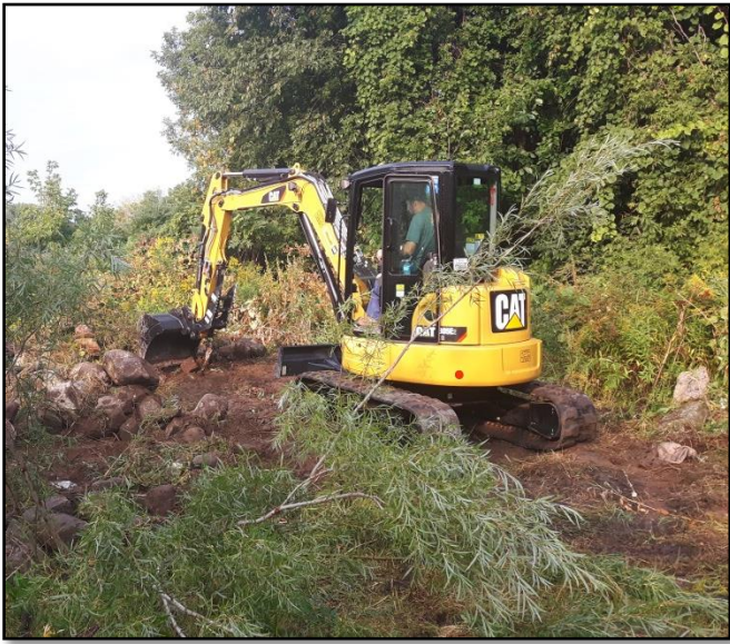
Photo 1. Récupération des roches de calibre 220-550 mm
