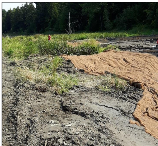
Photo 12. Remblai de l'ancien cours d'eau
