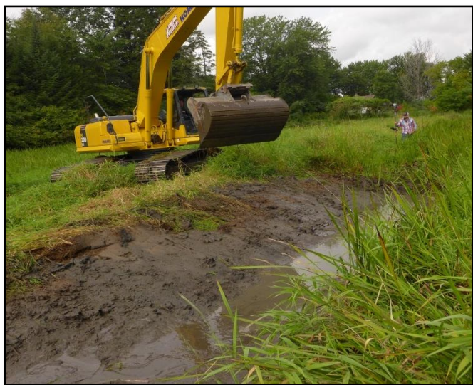
Photo 7. Nettoyage du cours d'eau en amont du tracé
