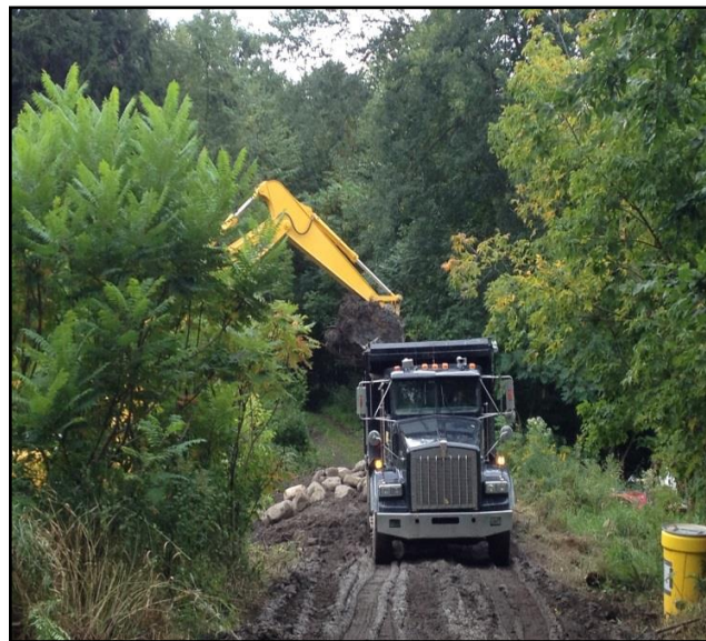
Photo 20. Transport du matériel excavé vers le site de dépôt
