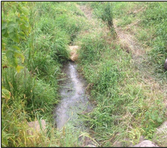
Photo 21. Boudin de paille filtrant les sédiments
