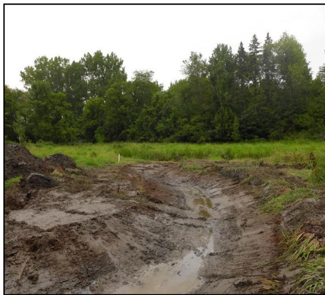
Photo 10. Excavation du cours d'eau – retrait de la couche argileuse
