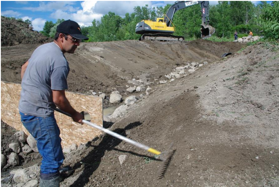
Immédiatement après les travaux d'excavation, la surface perturbée a été ensemençée.
