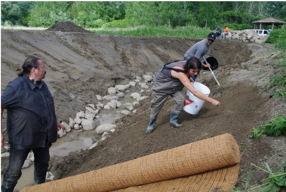
Une membrane dégradable a été étalée sur les talus.
