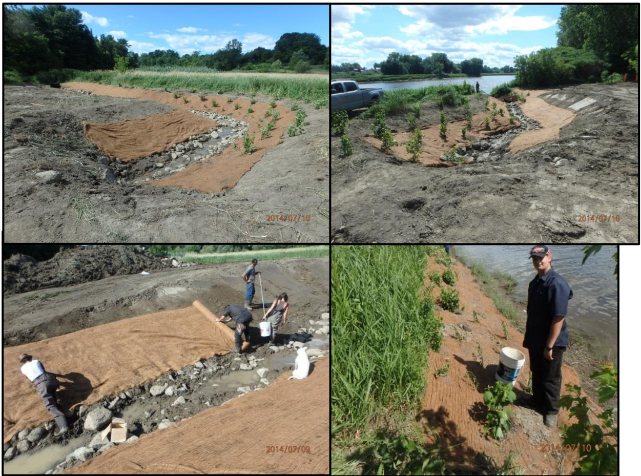
Figure 7. Photos de la végétalisation et stabilisation des aménagements prises le 10 juillet 2014.
